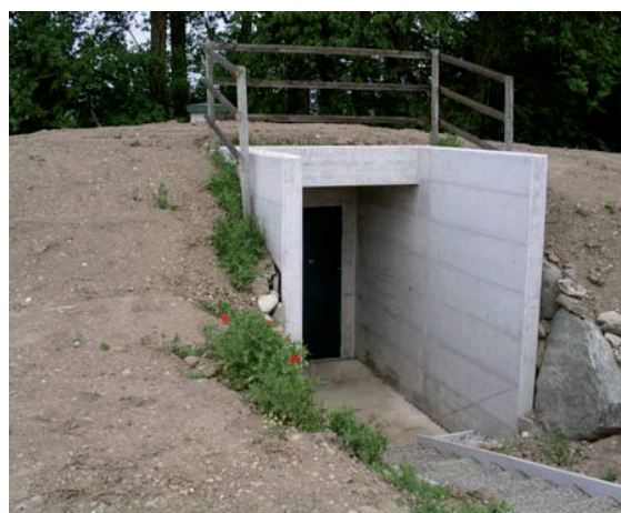
Le local sous-terrain abritant, en bas de la conduite, la turbine et le transformateur.
