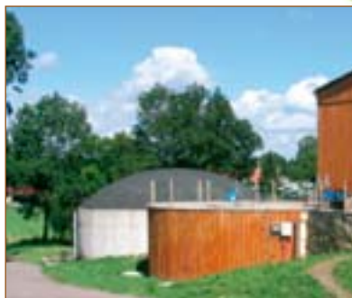
Photo 7 : Installation de l'EARL les Brimbelles (source Trame)
